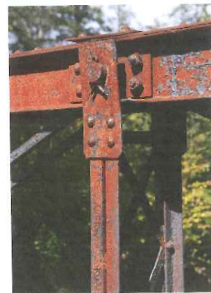
图 1-28 钢铁的腐蚀
