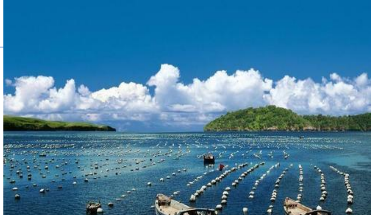
浙江江厦潮汐电站
